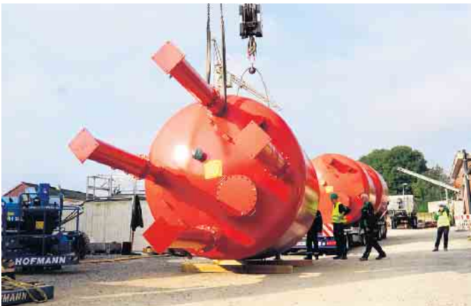
Insgesamt sechs große Stahlbehälter mit einem Durchmesser von rund 3,4 Metern durch einen 200 Tonnen Kran eingesetzt.
