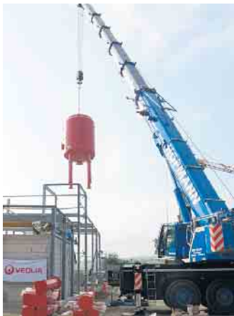
Die einzelnen Stahlbehälter werden an ihren Platz gehoben.
