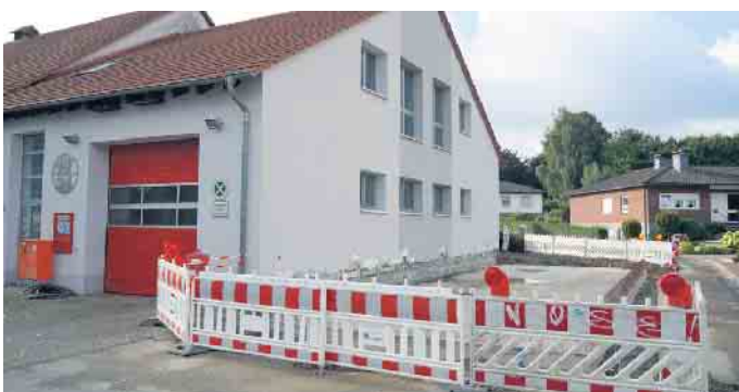
Auch in Hembsen wurde mit den Arbeiten begonnen, ein großer Dank gilt den angrenzenden Nachbarn für das Verständnis während der Bauzeit.
