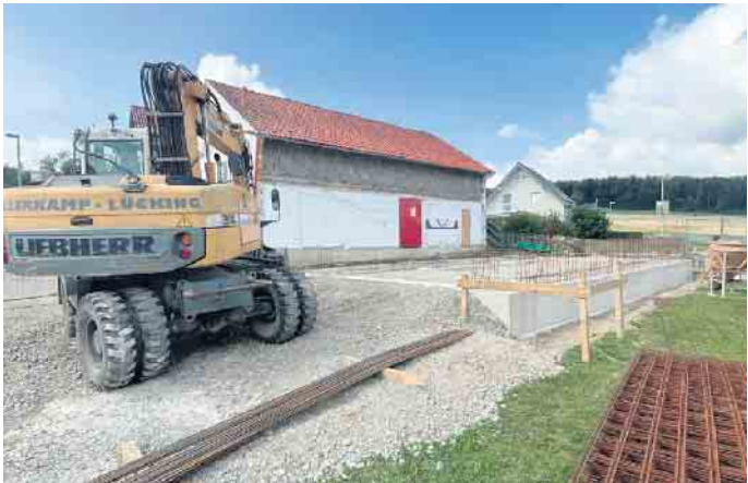
Im August wurde mit den ersten Arbeiten in Schmechten begonnen.
