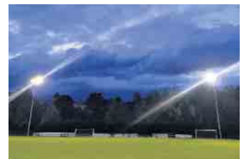
Die neue Flutlichtanlage sorgt neben der Reduzierung des Stromverbrauchs auch für eine optimale Ausleuchtung in den Abendstunden. (Foto: Michael Klages)
