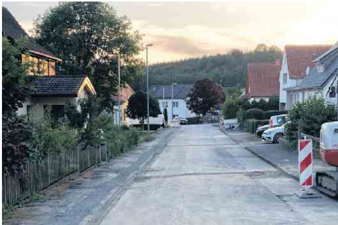
Die „Schulbreite“ in Siddessen wird ab dem 12. August 2024 ausgebaut.
