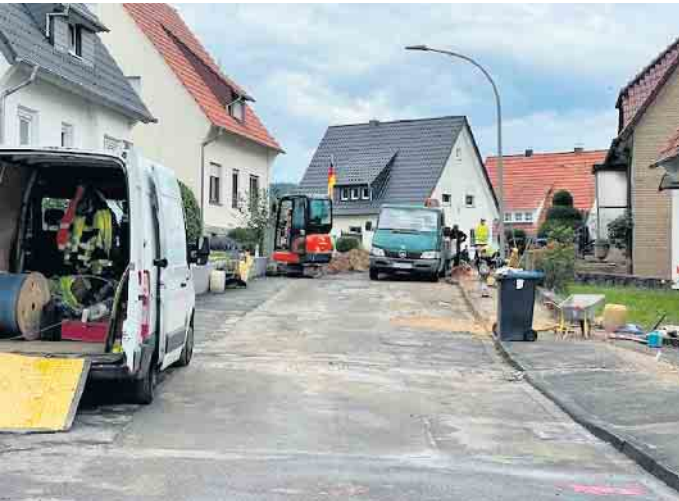
Die Fatimastraße wird in der gesamten Länge ausgebaut.
