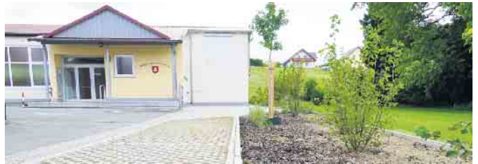
Das Dorfgemeinschaftshaus wurde um einen Anbau erweitert, sechs weitere Stellflächen konnten ebenfalls entstehen.
