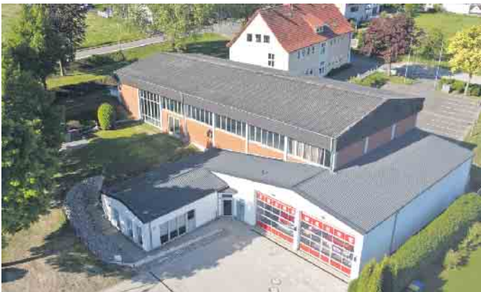
Blick auf das modernisierte Feuerwehrgerätehaus in Istrup. (Drohnenaufnahme: Robert Warneke)
