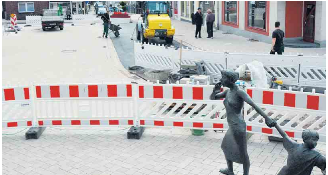
Die Bahnhofstraße ist aufgrund von Baumaßnahmen voll gesperrt.
