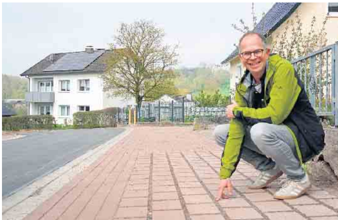
Die Arbeiten in Siddessen wurden abgeschlossen. Alexander Frewer (Betriebsleiter KuBra) hat die Baumaßnahme seitens der Stadt Brakel begleitet.
