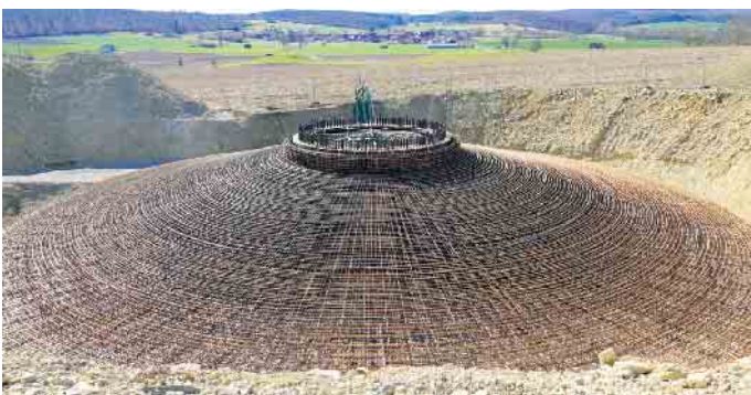
Hier wird eine der acht Anlagen des Windparks entstehen, im Hintergrund liegt die Ortschaft Schmechten.
