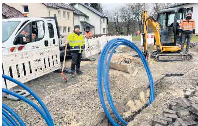
Die blauen Glasfaserleitung werden in der Straße verlegt. Foto: sewikom
