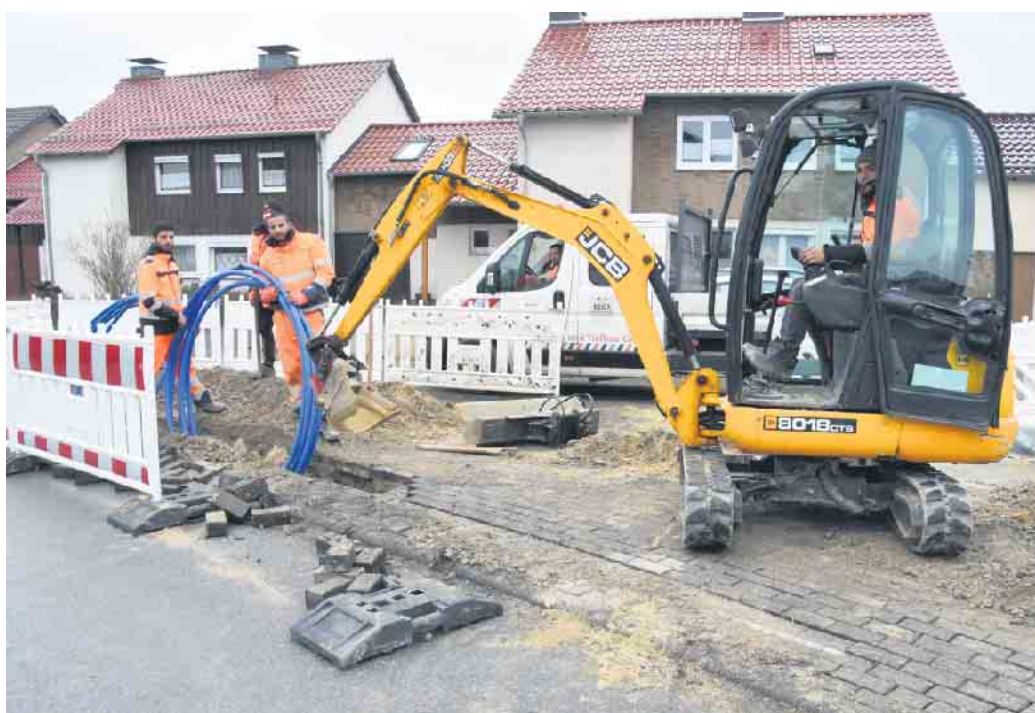
In Brakel „Am Heineberg“ geht der Ausbau des Glasfasernetzes voran. Von den Straßen aus werden die Gebäude mit den Hausanschlüssen versehen. Foto: sewikom
