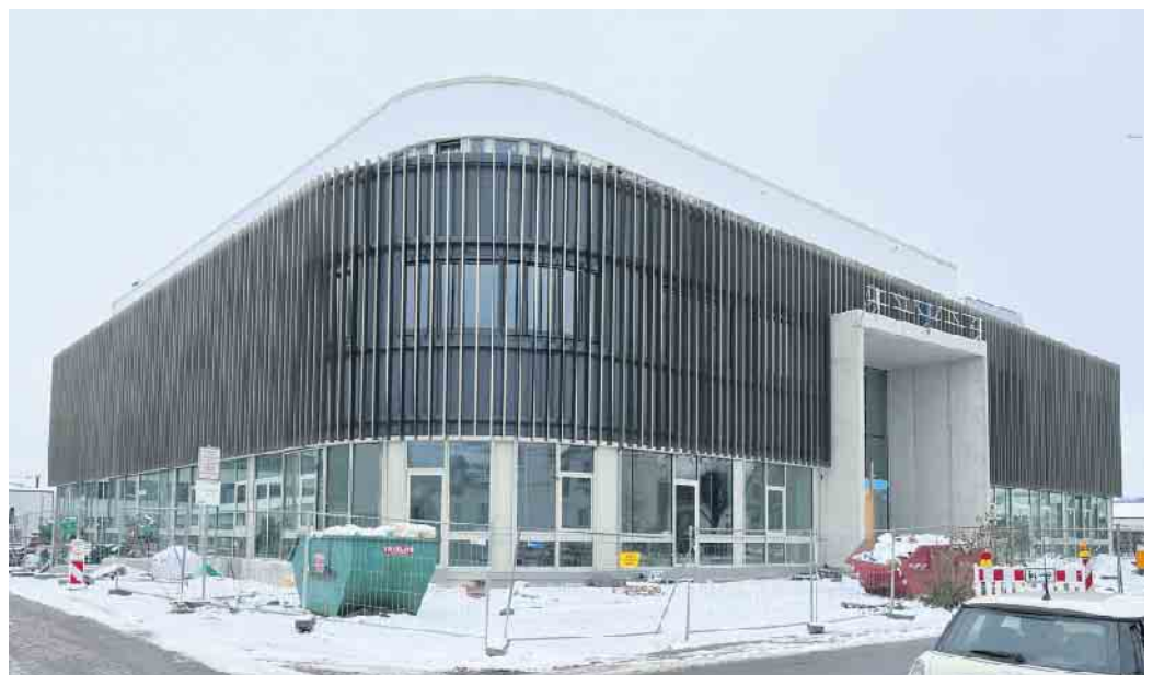
Die Realisierung des Bildungscampus Handwerk in Brakel ist auf der Zielgeraden. Foto: RSK/Peter Knobloch
