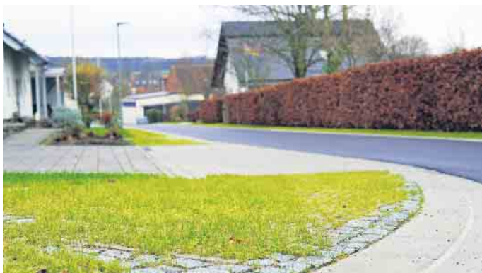
Die Randbereiche der Straße wurden größtenteils mit einem grauen ÖKO-Pflaster - sogenannten Rasenkammersteinen - ausgeführt.
