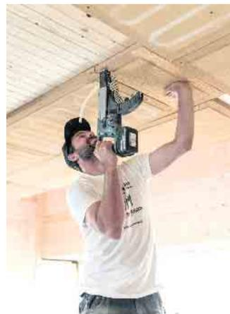
Trockenbau-Lehmputzplatten lassen sich einfach verschrauben oder verkleben. Das aufwendige Anmischen und manuelle Aufbringen des Putzes auf Wand- oder Deckenflächen kann man sich so ersparen. Foto: DJD/Naturbo
