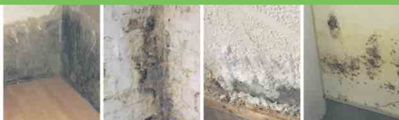
Defekte Horizontalsperre
