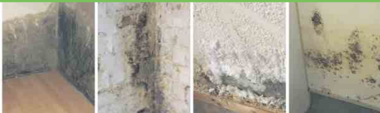
Defekte Horizontalsperre Querdurchfeuchtung Ausblühungen Schimmelbefall
