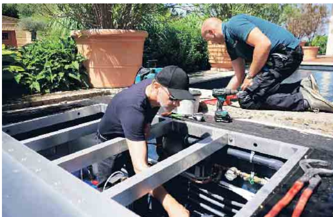
Arbeiten am Technischacht. Foto: Rambow Pooldesign/akz-o
