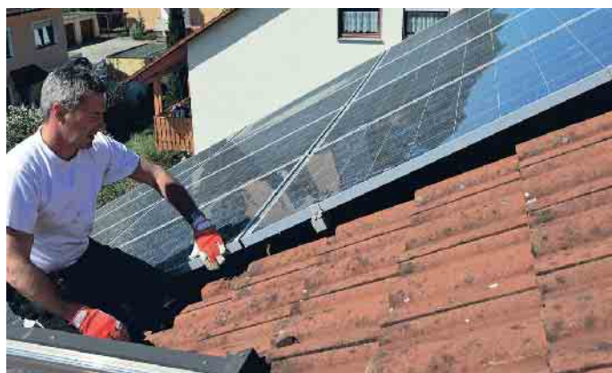
Der qualifizierte Dachdecker prüft die Befestigungen der Solarmodule und begutachtet die Unterkonstruktion im Rahmen des DachChecks.
