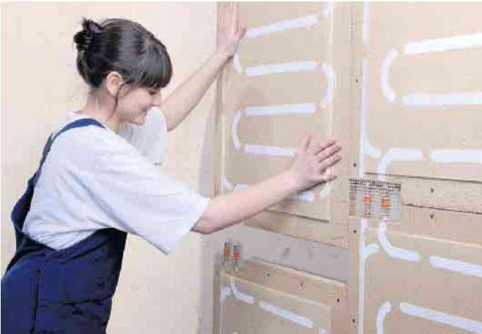
Eine angenehme und energiesparende Wandheizung ist mit Lehmbauplatten, die ab Werk mit Heizungsrohren vorbestückt sind, schnell und einfach einzubauen. Foto: DJD/Naturbo
