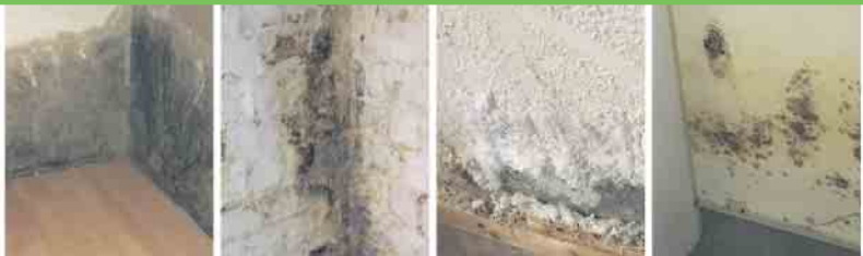
Defekte Horizontalsperre Querdurchfeuchtung Ausblühungen Schimmelbefall
