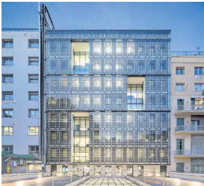
Gut für Klimabilanz und Energieausbeute: Eine vorgehängte BIPV-Lösung an der Fassade einer Gewerbeimmobilie. Copyright: AGC Glass Europe
