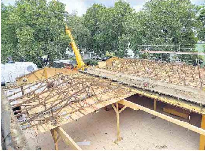
Baustelle Dach. Im Inneren stehen noch die Stützpfeiler, die das marode Dach lange gesichert haben. Foto: bv
