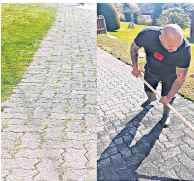
Reinigung von Fugen vorher und nachher.
