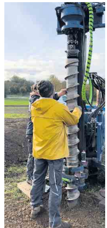
Brunnenbohrung im Naturprojekt am Butterberg
