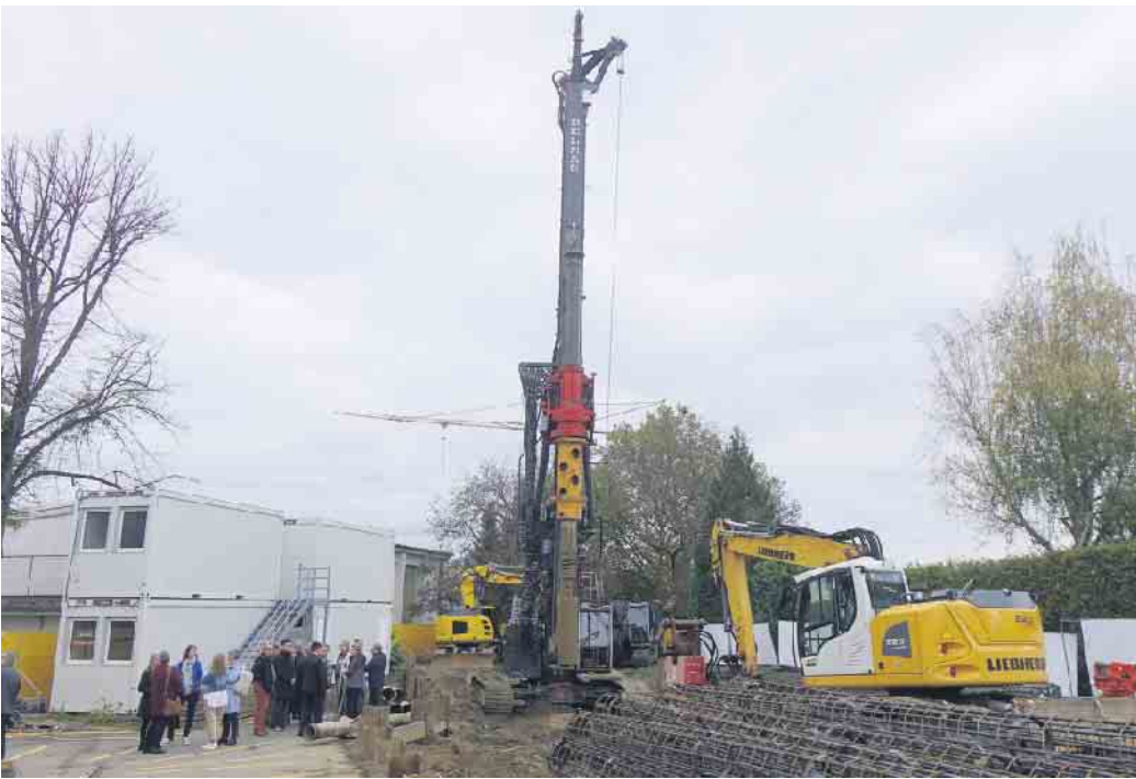
Die Gründung mit Verdrängungsbohrpfählen gegen die Baurisiken nahe der Sieg an Michaelisbergstraße ist aufwändig.
