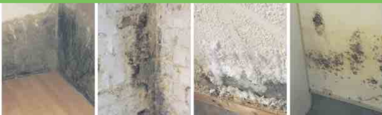
Defekte Horizontalsperre
