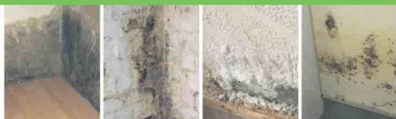
Defekte Horizontalsperre
