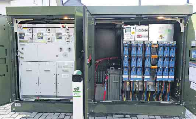
Blick ins Innere einer Digitalen Strom-Ortsnetzstation. Mitte hinten in grau der Transformator für die Spannungsumwandlung von der Mittel- zur Niederspannung im Ortsnetz.
