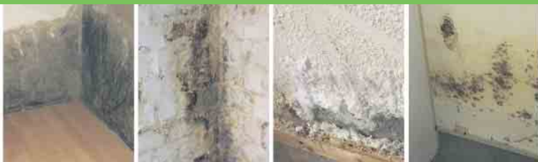
Defekte Horizontalsperre Querdurchfeuchtung Ausblühungen Schimmelbefall
