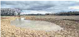
180 Tonnen Ton und Lehm sind verbaut worden
