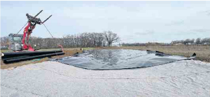
Folienverlegung - Grossgewässer am Butterberg
