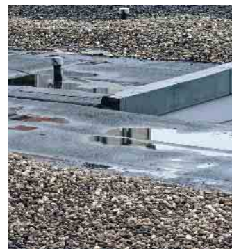
Ein Flachdach wie dieses mit stehendem Wasser und Rissen in den Dachbahnen sollte dringend saniert werden. Foto: Datenschutz-Stockfoto/shutterstock/Triflex/akz-o
