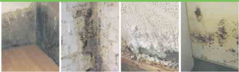
Defekte Horizontalsperre Querdurchfeuchtung Ausblühungen Schimmelbefall
