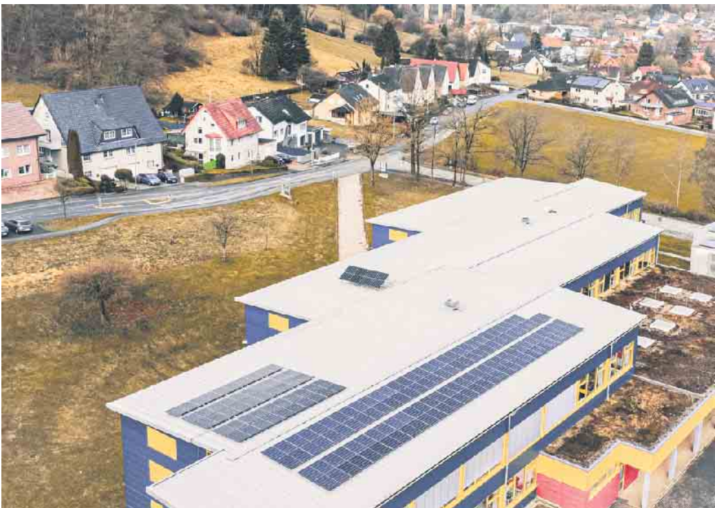
Blick aus der Luft auf die PV-Anlage am Schulzentrum
