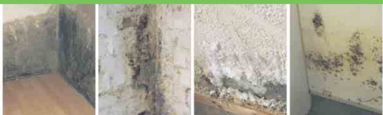
Defekte Horizontalsperre Querdurchfeuchtung Ausblühungen Schimmelbefall
