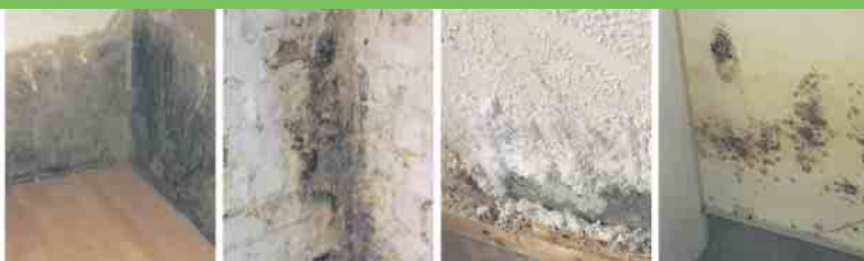
Defekte Horizontalsperre
