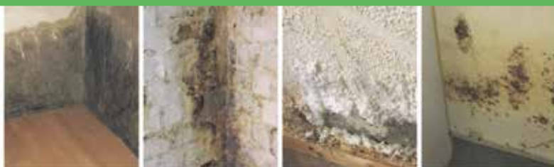
Defekte Horizontalsperre
