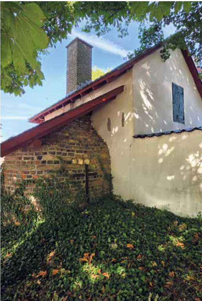
Der angebaute Ofen
