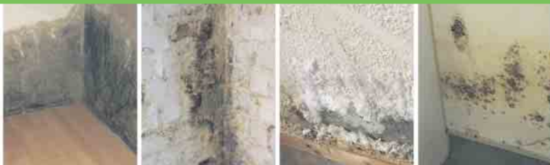
Defekte Horizontalsperre
