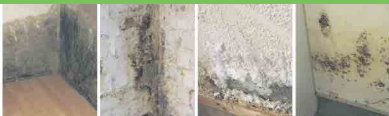
Defekte Horizontalsperre Querdurchfeuchtung Ausblühungen Schimmelbefall
