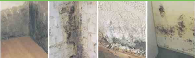
Defekte Horizontalsperre Querdurchfeuchtung Ausblühungen Schimmelbefall
